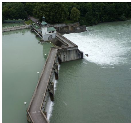
Der Augsburgener Hochablass vor dem Umbau zum Wasserkraftwerk.
